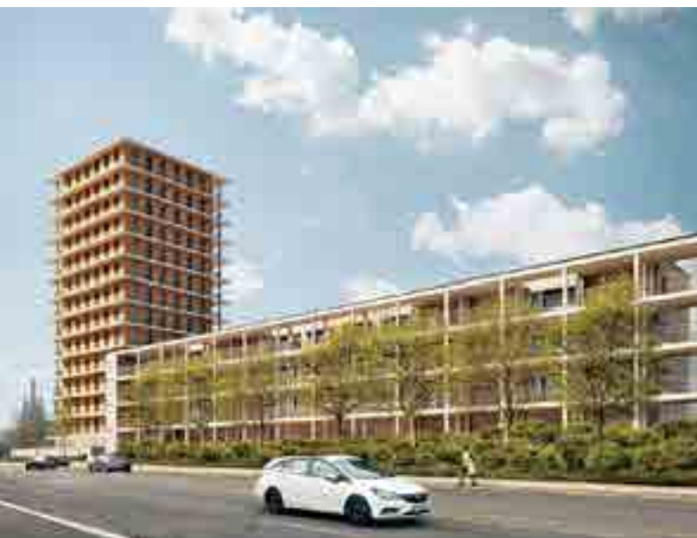
In zwei Gebäudezeilen, die das Hochhaus ergänzen und ebenfalls in Holz-Hybrid-Bauweise errichtet werden, entstehen weitere Wohnungen
