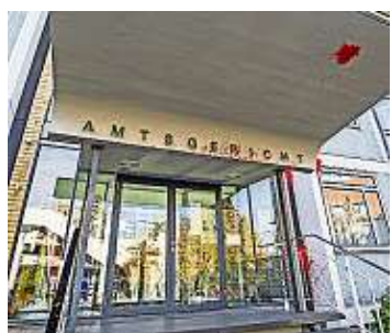
Rote Farbe im Eingangsbereich.
