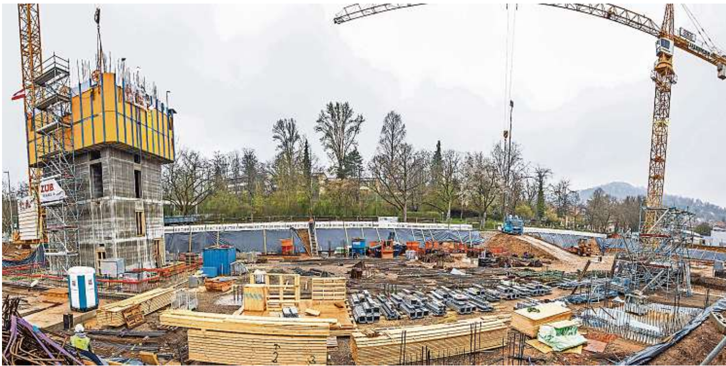
Die gelbe Gleitschalung auf dem Kern des geplanten Hochhauses dient dazu, dass Beton hineingegossen wird. Die Gleitschalung wird immer weiter hochgezogen bis zum 14. Stock.
