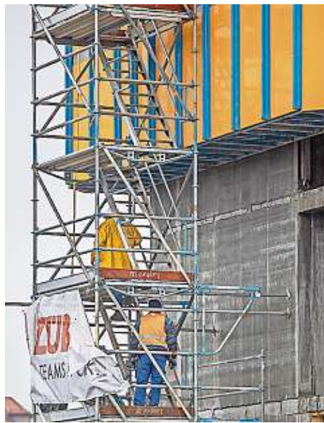
Die Mitarbeiter des Generalunternehmers Züblin aus Karlsruhe dürfen sich momentan keine Pause leisten.
