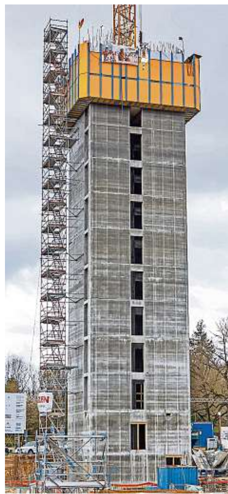
Jeden Tag 4,30 Meter höher: Stockwerk für Stockwerk wächst Carl, an dem ohne Unterbrechung gearbeitet wird.
