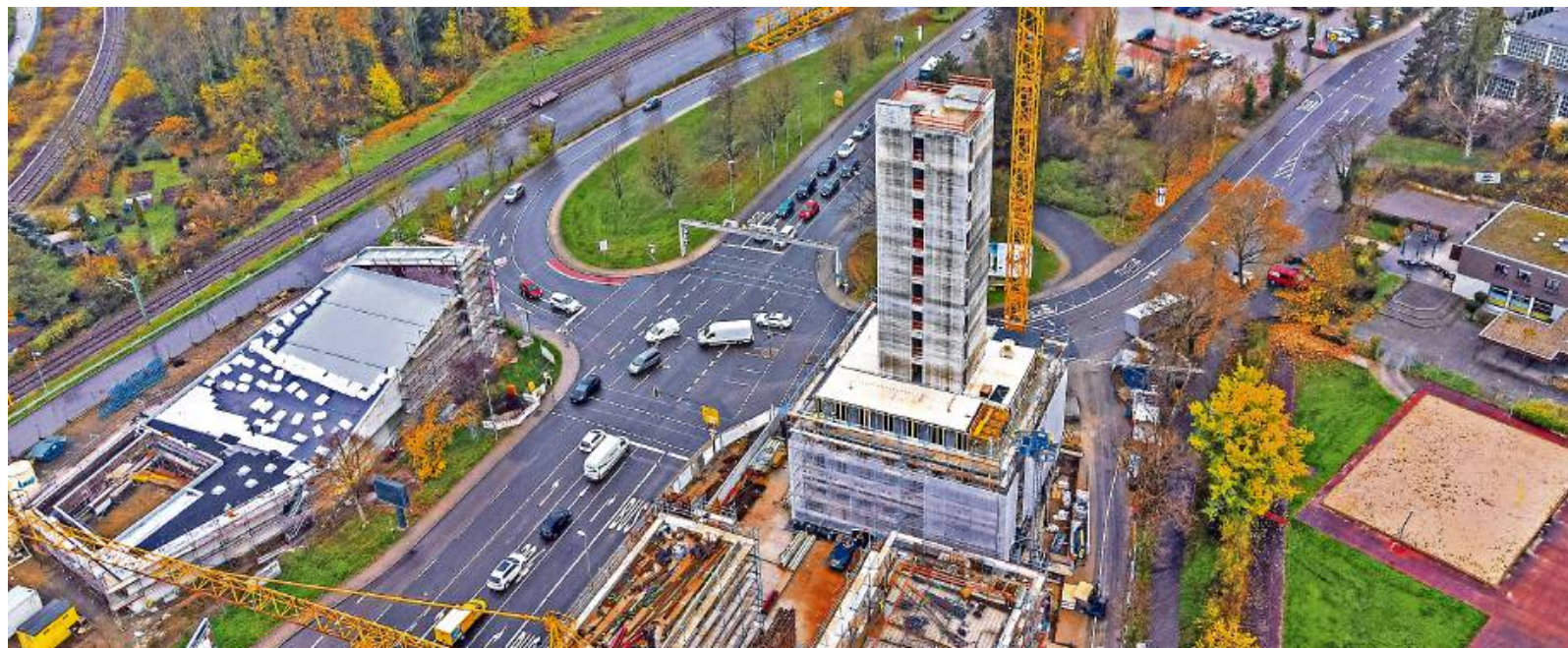
Um den Betonkern des Hochhauses Carl an der Carl-Hölzle-Straße werden die Stockwerke aus Holz Stück um Stück aufgesetzt. Auf der linken Seite entsteht der Neubau der neopostolischen Kirche. FOTOS: MEYER
